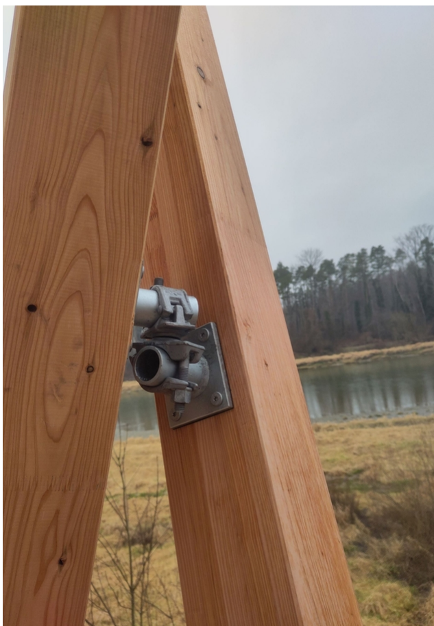
Assemblage des barreaux
