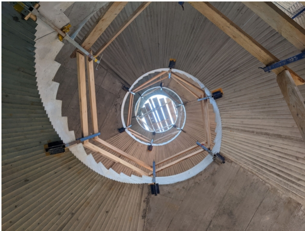
Escaliers central du «pilier de la justice»
