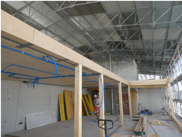
Aufstockung unter dem Notdach
