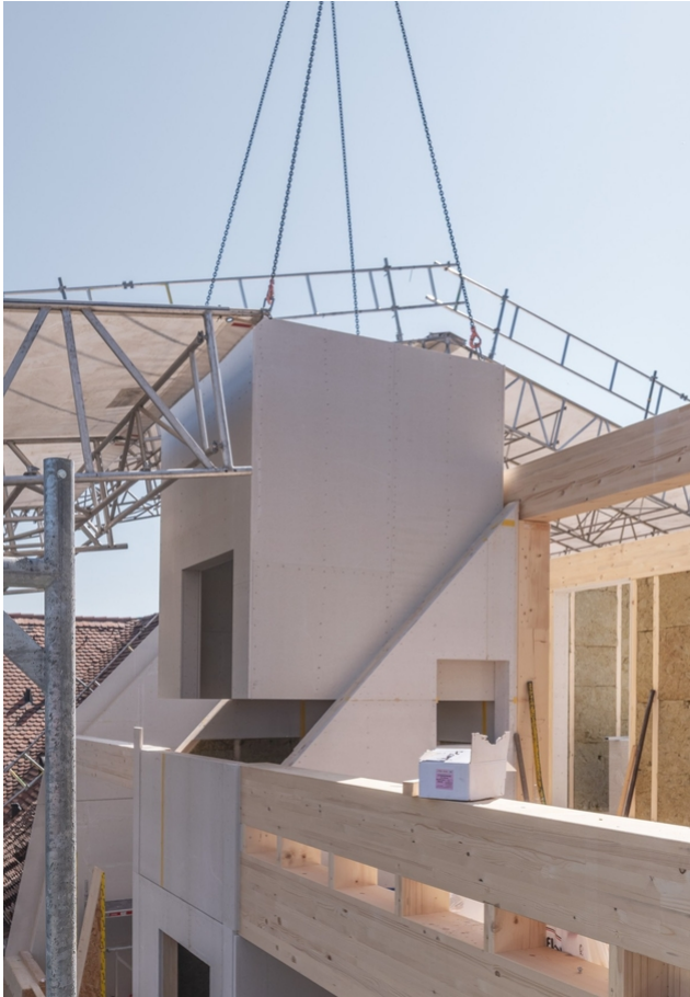
Vorgefertigte Module werden bauseits eingebracht
