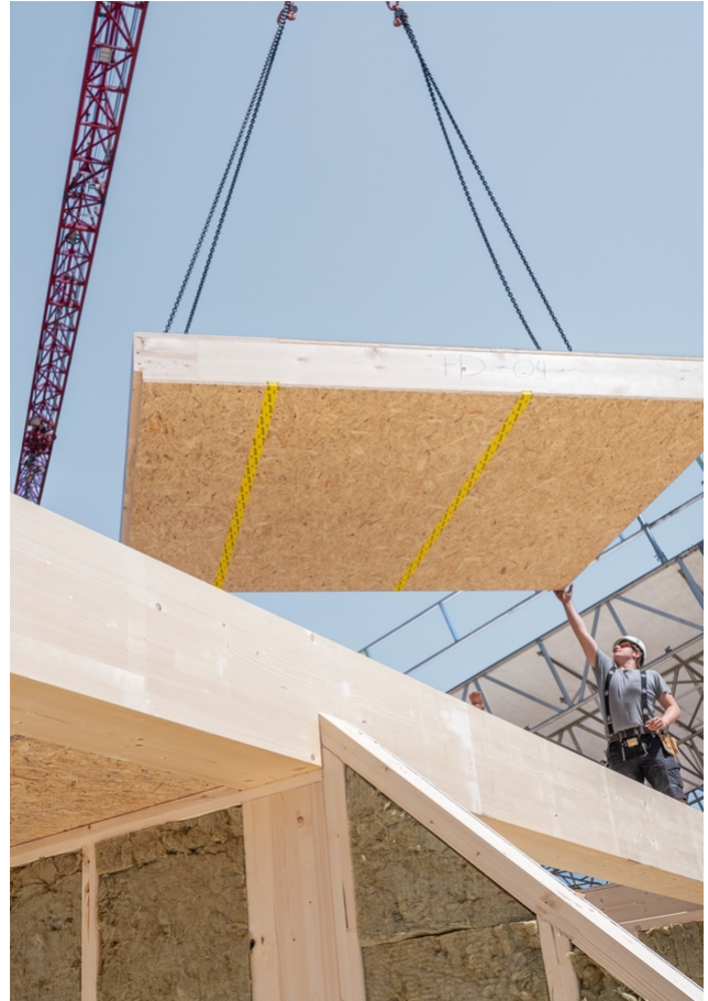
Einbringen von Geschosselementen
