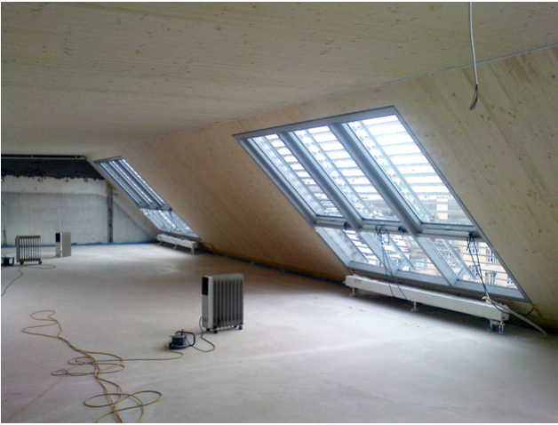
Dachfenster einsetzen
