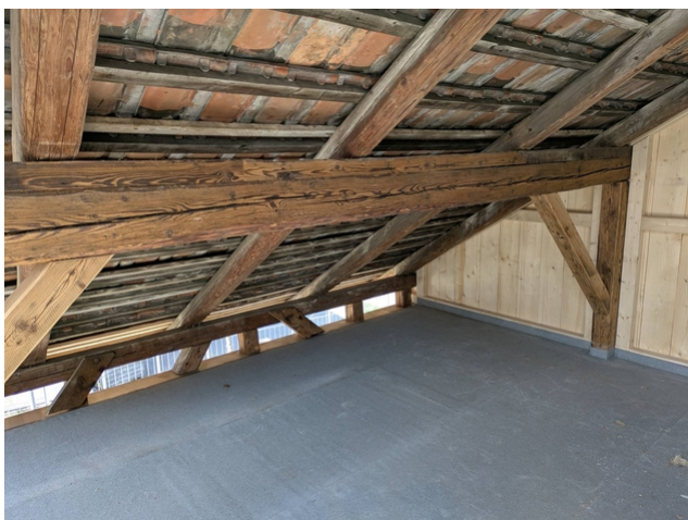
Verstärkung der bestehenden Dachkonstruktion mit Altholz.
