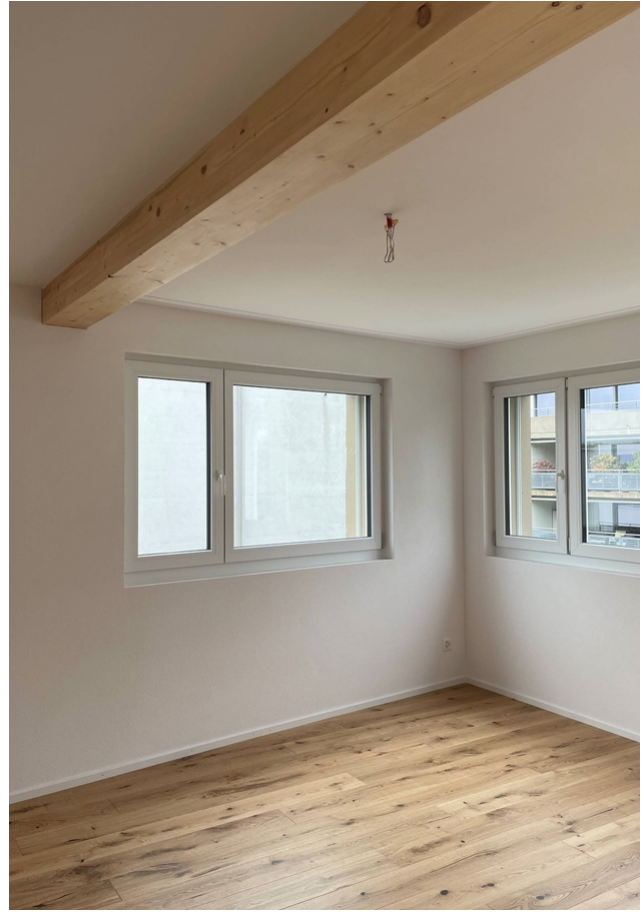
Unterzug aus Brettschichtholz
