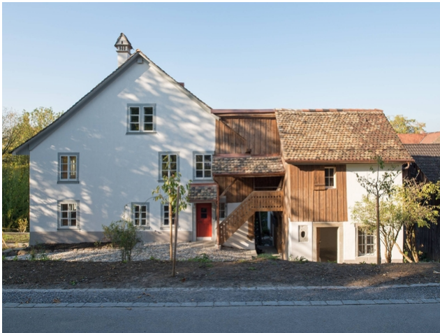
Ansicht von der Strassenseite
