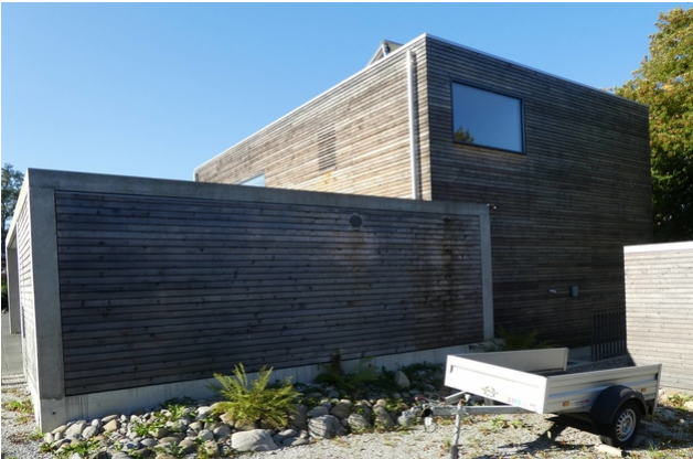
Fassade nach 5 Jahren
