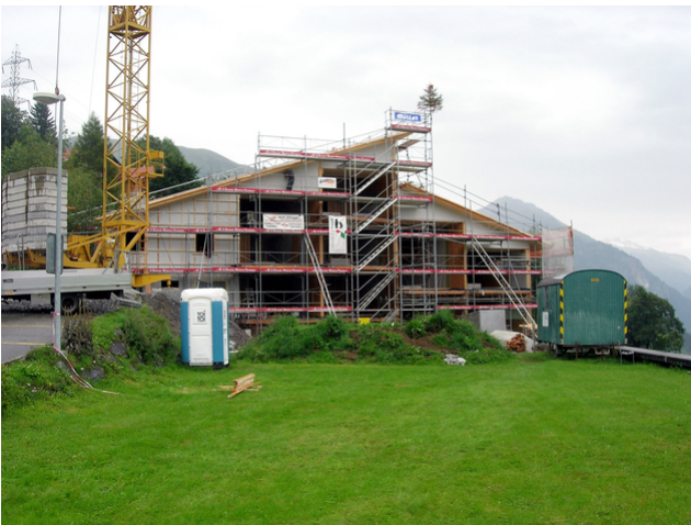
Rohbau des Gebäudes
