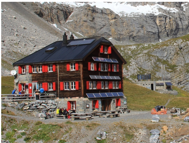
Die Lämmerenhütte vor der Erweiterung
