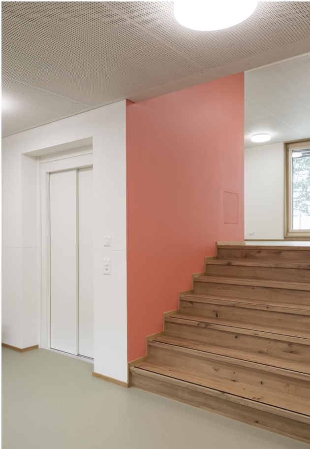
Treppengänge mit Eiche Massivholzplatten
