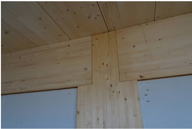
Auflager der Träger auf den Stützen
