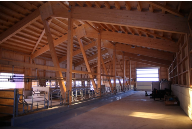
Rahmenkonstruktion im Laufstall
