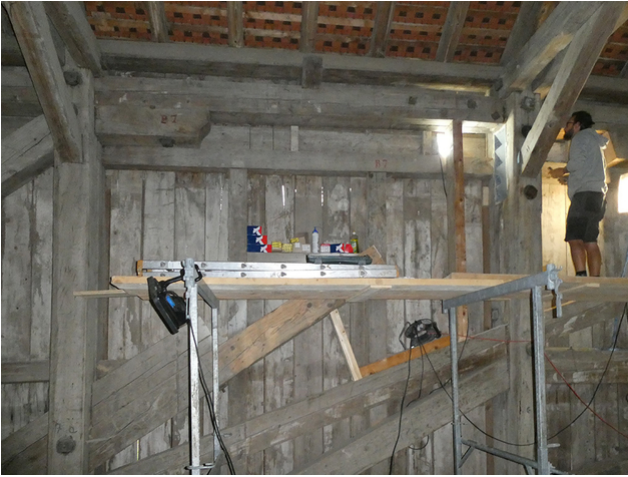
Strebensanierung der Brücke
