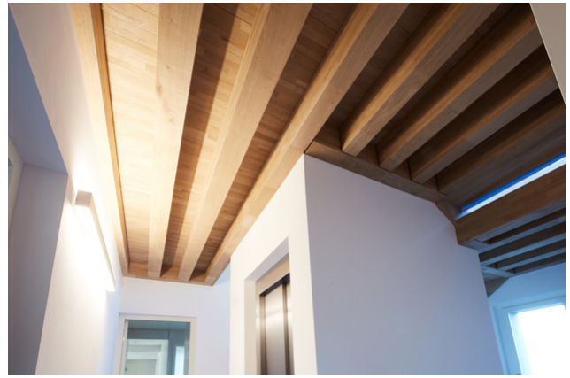
Treppenhaus und Liftschacht in Holzbauweise
