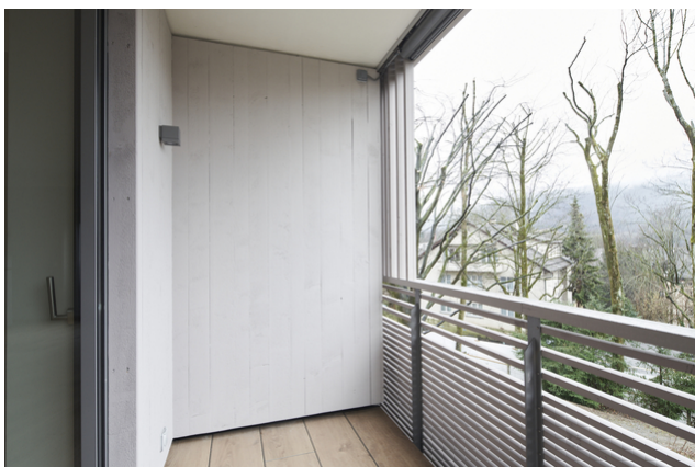
Holz an der Fassade und an den Balkonen
