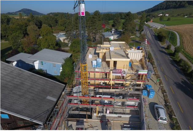
Der Holzbau wird aufgerichtet
