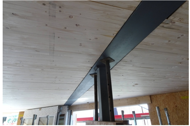
Deckenintegrierter Stahllunterzug
