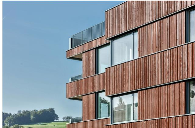
Die leichte Holzfassade wurde vor den massiven Stahlbetonbau angehängt. Die Holzfassade mit anspruchsvollen Blechschürzen in komplexen Geometrien bildet die Aussenhülle dieser Überbauung.
