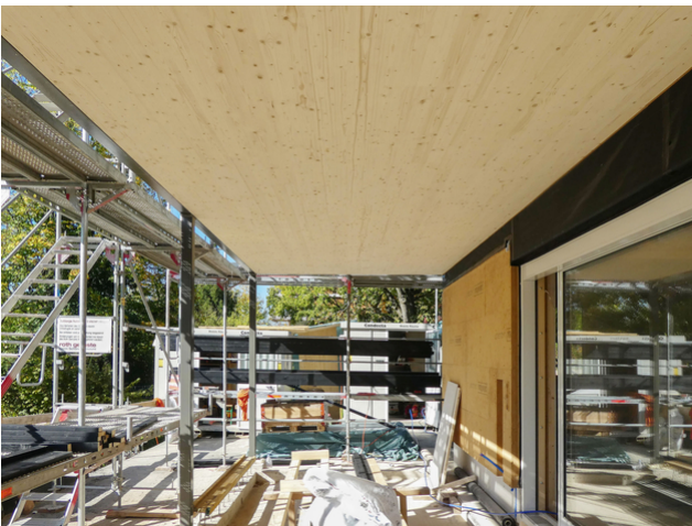
Eine der Holzterrassen während den Bauarbeiten
