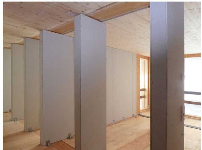
Blick ins Innere: Im Vordergrund sind die Stützen zu sehen, welche die Decke tragen
