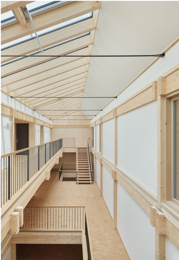
Die Tragkonstruktion ist bis auf die Zugstangen aus Holz.
