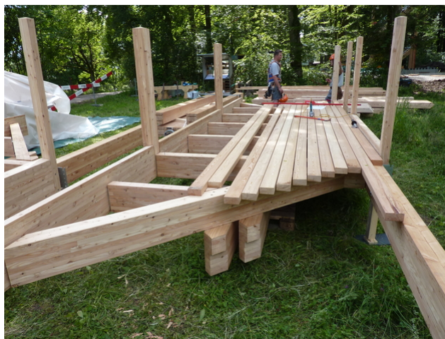
Zusammenbau des Turms
