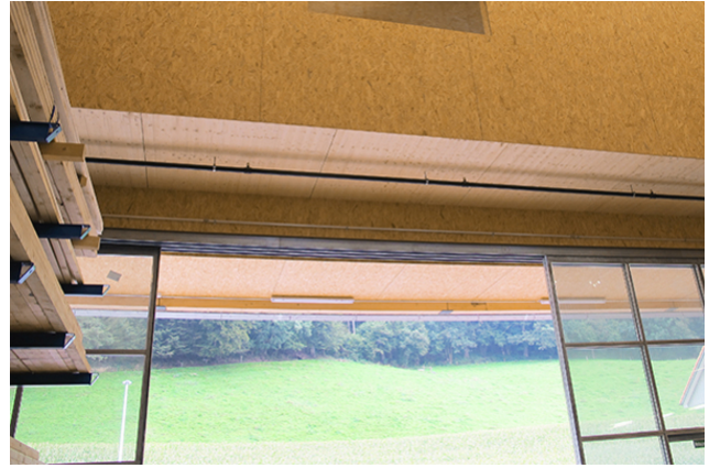
Schiebetor unter dem Bürotrakt – 15 m frei tragend mit minimalster Durchbiegung
