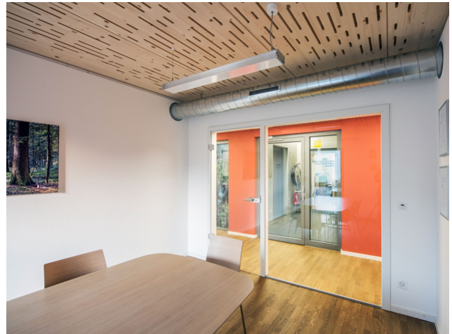
Merkmal: Lignum Deckenelemente mit Akustiklöchern
