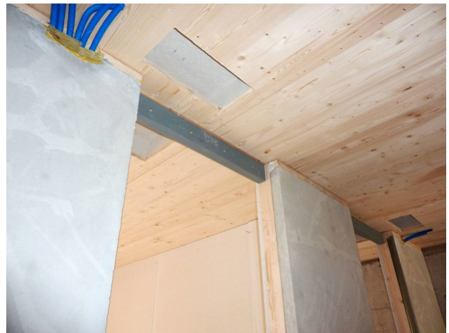
Wandbeschichtung als Wärmespeicher
