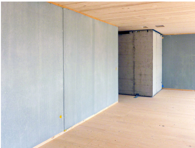
Ansicht Holz-Beton-Wand
