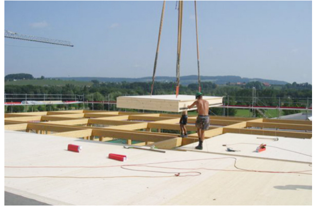
Montage von Dachelementen
