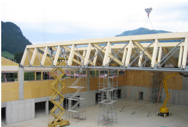
Montage von Fachwerkträgern
