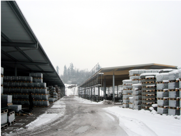
Alte und neue Überdachung
