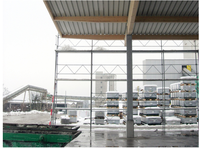
Stahlstütze und Holzbinder
