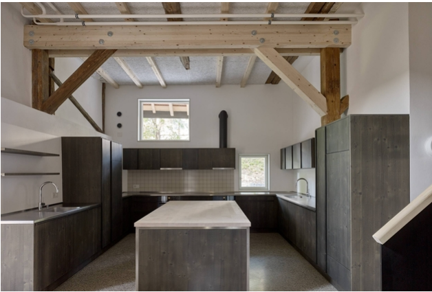
Ertüchtigtes Tragwerk über der Küche
