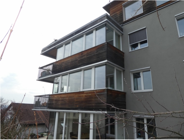
Fassade nach 10 Jahren
