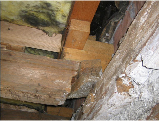
Trägerunterstützung OG vor der Sanierung
