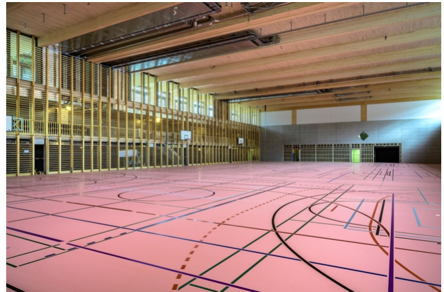
Die untenliegende 3-fach Turnhalle mit den überspannten Holzträgern (Länge: 35 m)
