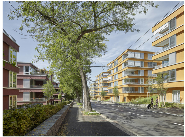
Strassenseite 1. und 2. Etappe
