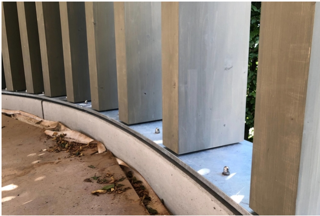
Stützen beim Pavillon
