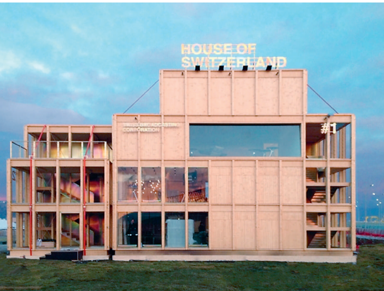
Das House of Switzerland, ein reiner Holzbau: Um es in Zürich aufzustellen, benötigte man nur vier Tage.
