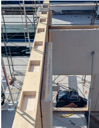
Die Taschen zur Aufnahme der Schubnocken sind in die Ober-/ und Untergurten eingefräst.
